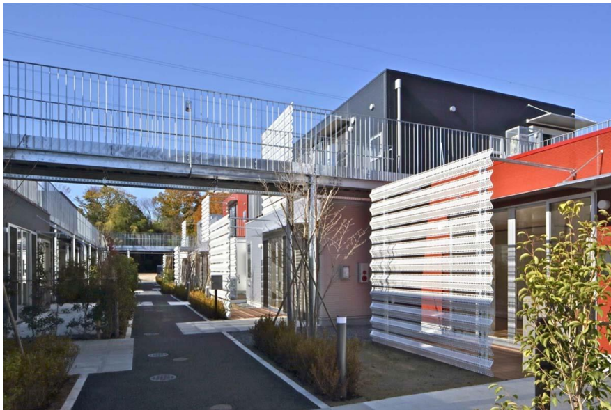
สะพานเชื่อมระหว่างตัวอาคาร
