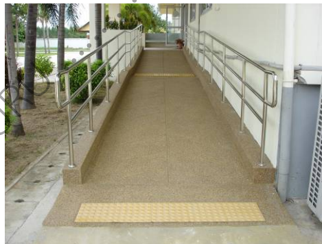
ทางลาดก่อคอนกรีตบล็อก ผิวทรายล้าง
