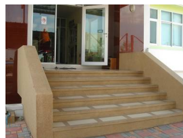
บันไดโครงสร้างคสล.ผิวทรายล้าง ควรมีราวจับกม ขนาด \varnothing 3-4 ซม.
